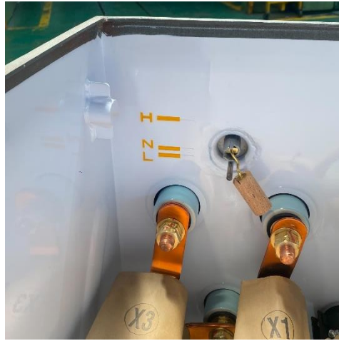
圖 2-3 50kVA 亭置式變壓器油面標示圖
