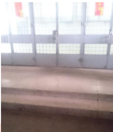
圖 364 現場出入口情況
