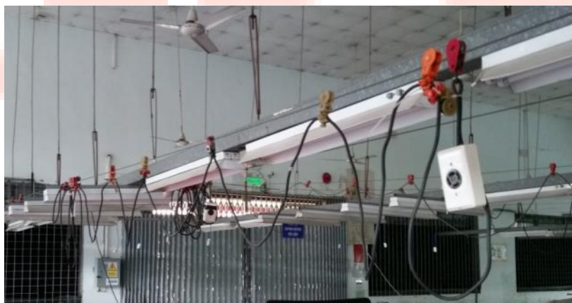
圖 347 裁剪區懸掛電線設置
