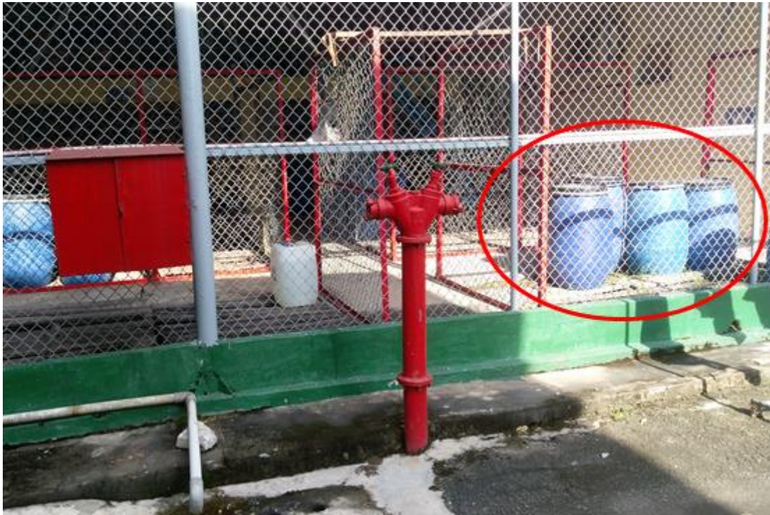
圖 380 藥劑倉庫放置現況
